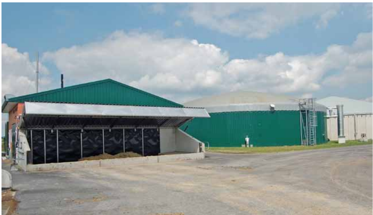
Feststoffaufnahme bei Biogasanlage
