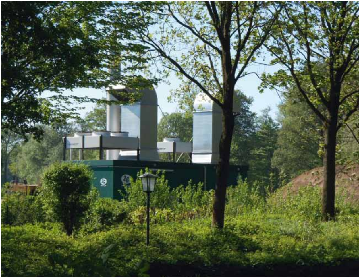
Satelliten-BHKW zur Versorgung der Ev. Akademie Loccum
