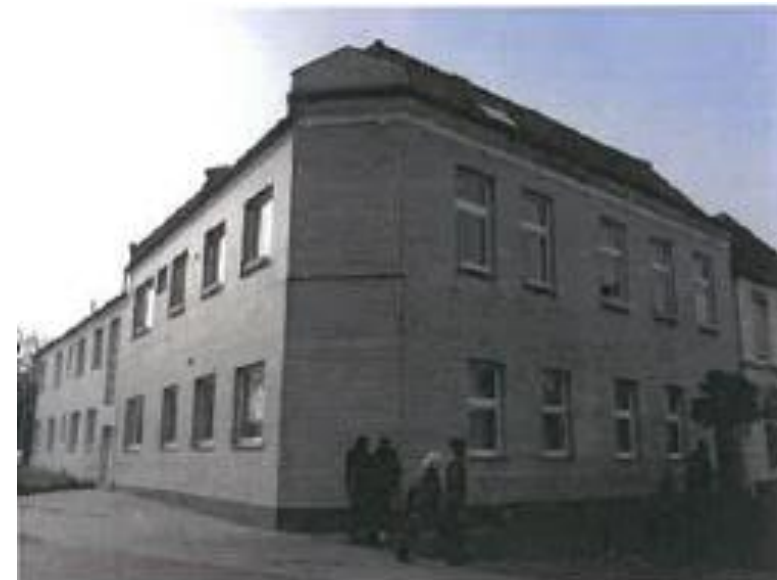
Heutige Situation / Eckgebäude Osterstraße 42/44
