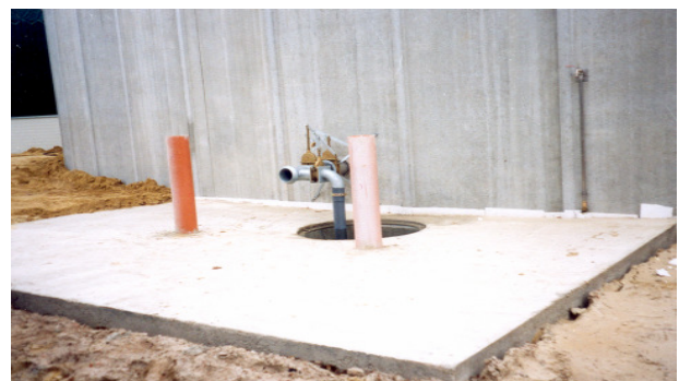
Abb. 6: Befestigter Abgabebereich mit Auffangbehälter
