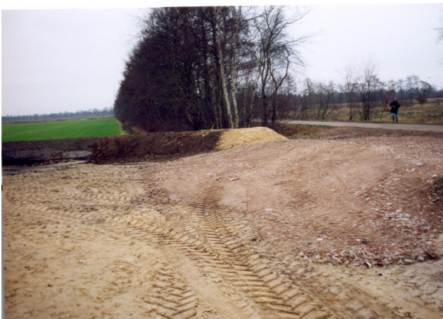
Abb. 12: Umwallung einer Biogasanlage in der Fertigung
