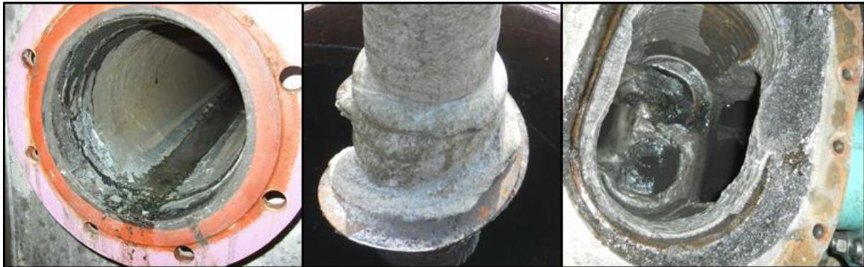
Abbildung 29: Unerwünschte Ablagerungen von MAP in Rohrleitungen und Aggregaten auf der Kläranlage Hildesheim
