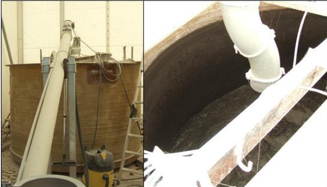
Abbildung 26: Die CSH-Partikel werden als sogenannte Bigbags ( $\cong 700$  kg CSH/Sack) mithilfe einer Schneckenpumpe in den Schlamm eingemischt
