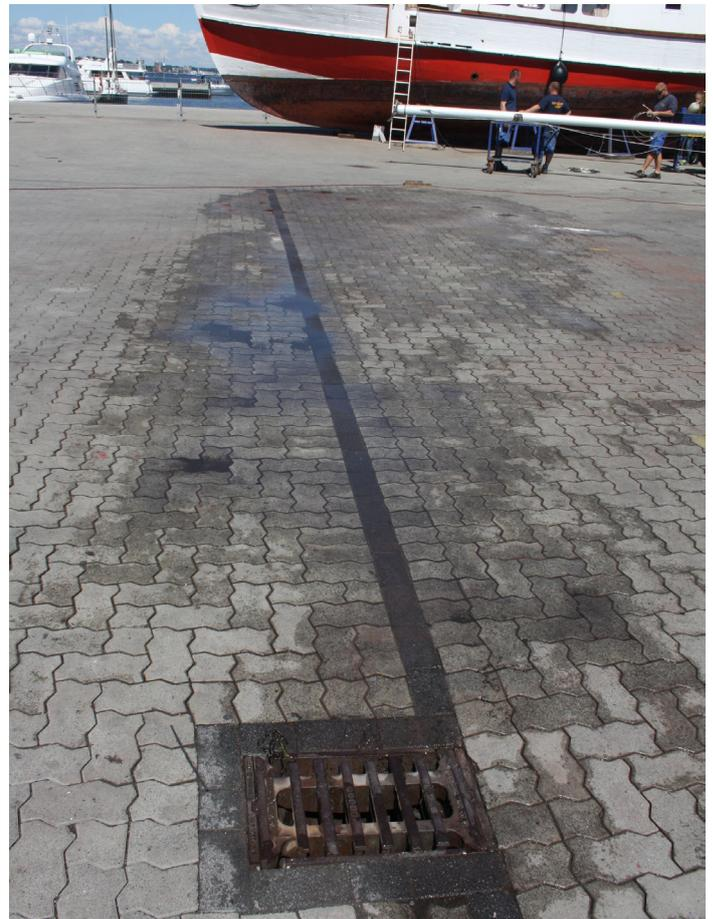
Abb. 3 Waschplatz mit Ablauf zu einem Zwei-Kammersystem
