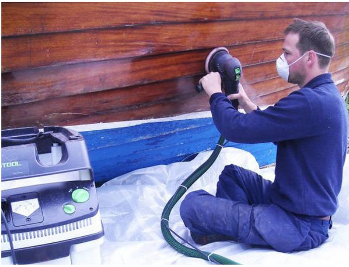
Abb. 4 Entschichtung mit Absaugvorrichtung, Atemschutz und Bodenplane
