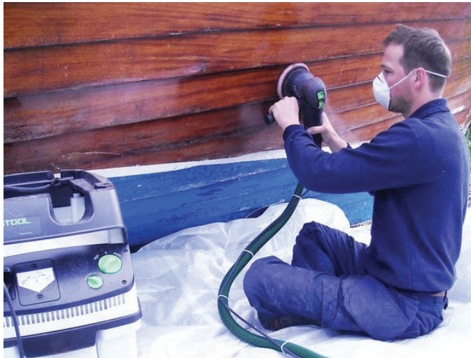
Abb. 4 Entschichtung mit Absaugvorrichtung, Atemschutz und Bodenplane
