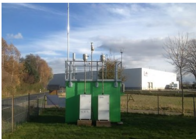
Abb. 5.161: DENI070 Salzgitter-Drütte (SROO) (Bilddaufnahme November 2013)
