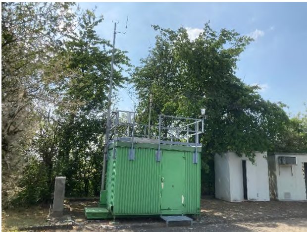
Abb. 5.196: DENI011 Braunschweig (BGSW) (Bildaufnahme Juni 2021)
