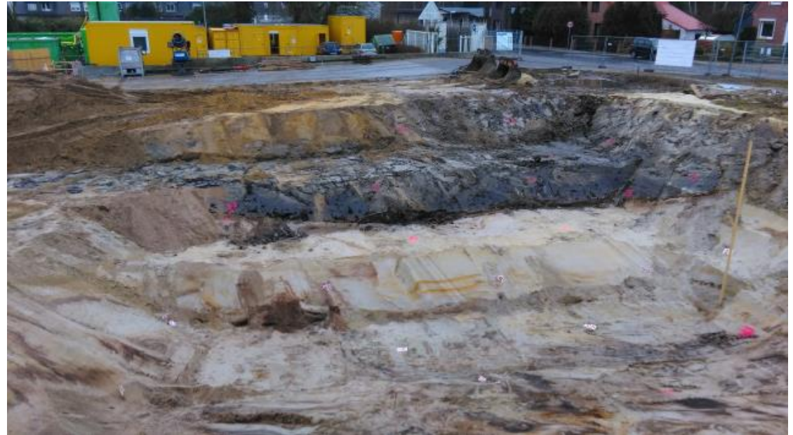
Nörtl. Hot Spot: Sanierungsbaugrube
