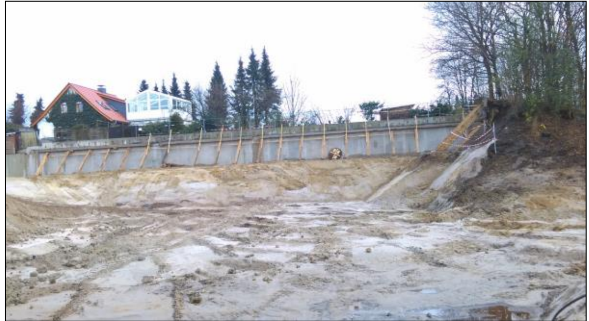
Südl. Hot Spot: Aushubtiefe bis zum Stauwasseranschnitt
