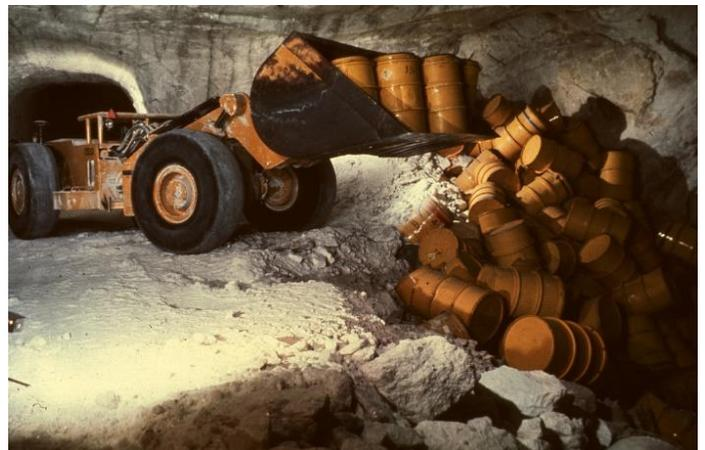
Abbildung 1: Ein Radlader kippt im Jahr 1975 Fässer mit radioaktivem Abfall in eine Einlagerungskammer der Schachanlage Asse II ab, Foto: BGE
