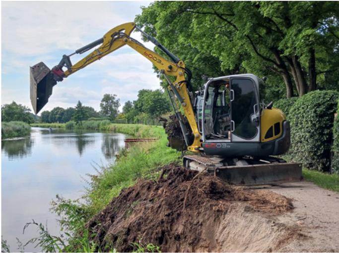
Abb. 23: Bei der Unterminierung von Deichen können Maßnahmen zur unmittelbaren Gefahrenabwehr notwendig sein. (Foto: Ingo Weinrich)
