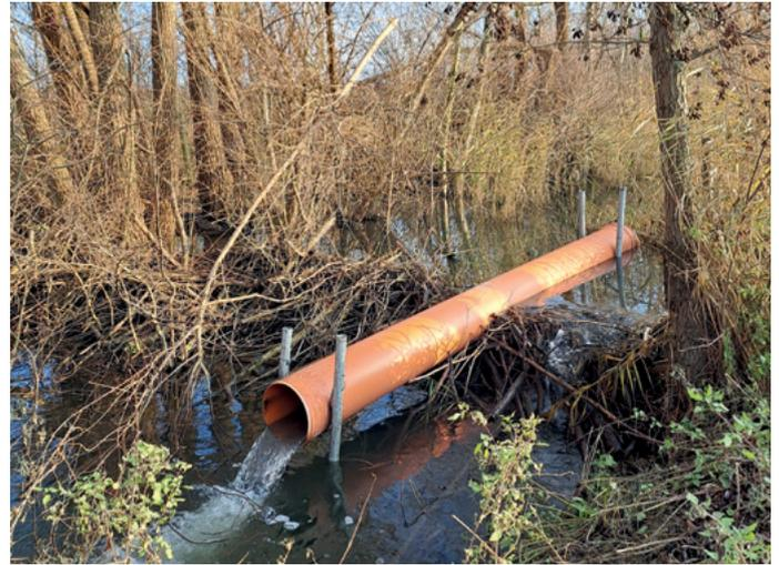
Abb. 24: Der Einbau einer Dammdrainage zur Reduktion des Wasserstandes kann im Einzelfall genehmigungspflichtig sein. (Foto: Julia Putze)
