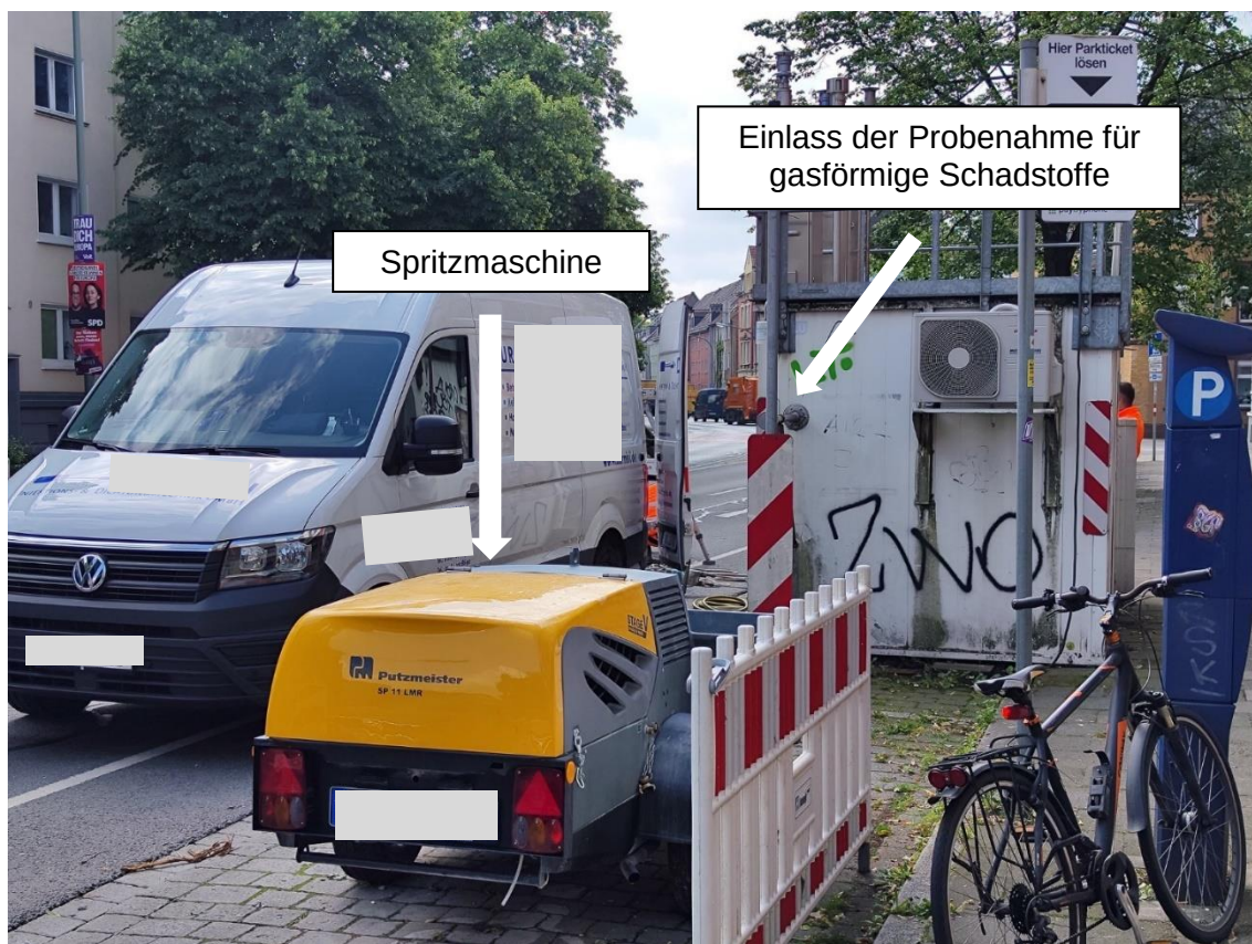
Abb. 4: Bauarbeiten am 28.05.2024 neben der Messstation DENI067
