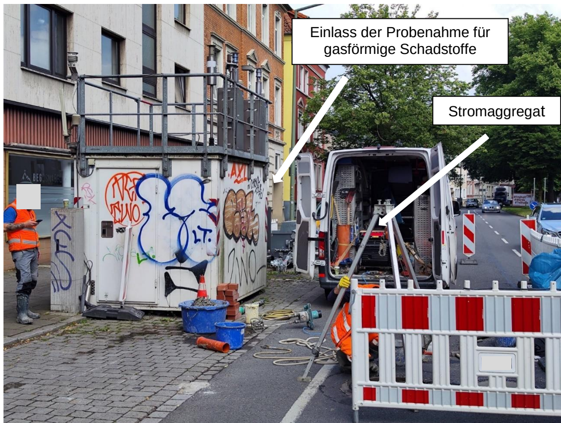
Abb. 3: Bauarbeiten am 28.05.2024 neben der Messstation DENI067
