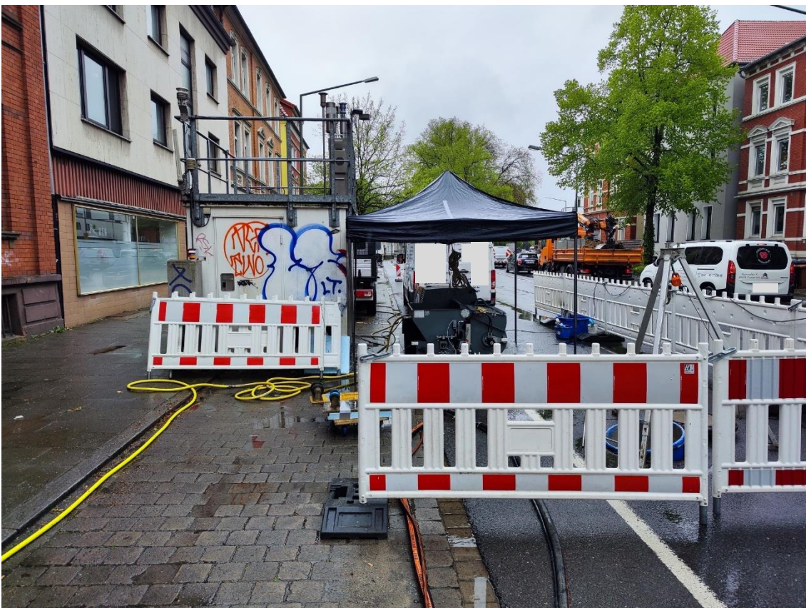
Abb. A.2: Bauarbeiten neben der Messstation DENI067
