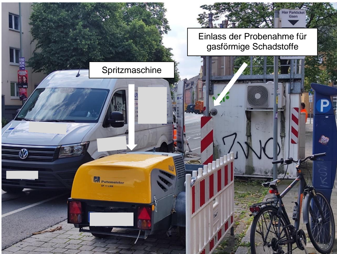
Abb. 4: Bauarbeiten am 28.05.2024 neben der Messstation DENI067
