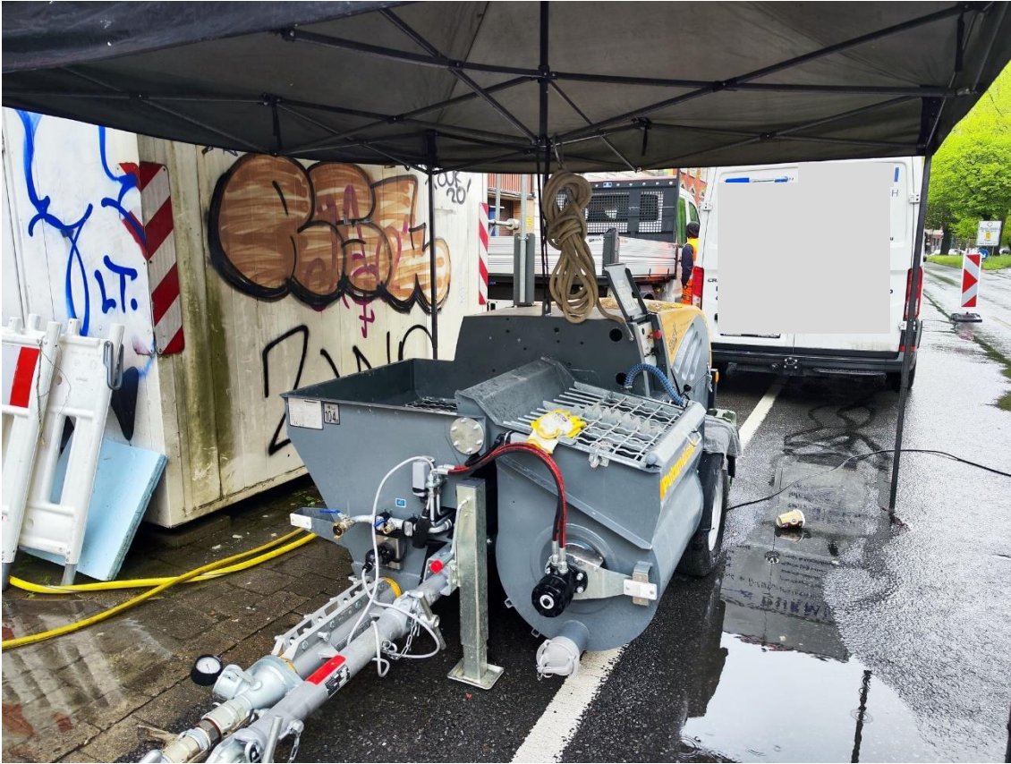
Abb. A.1: Bauarbeiten neben der Messstation DENI067
