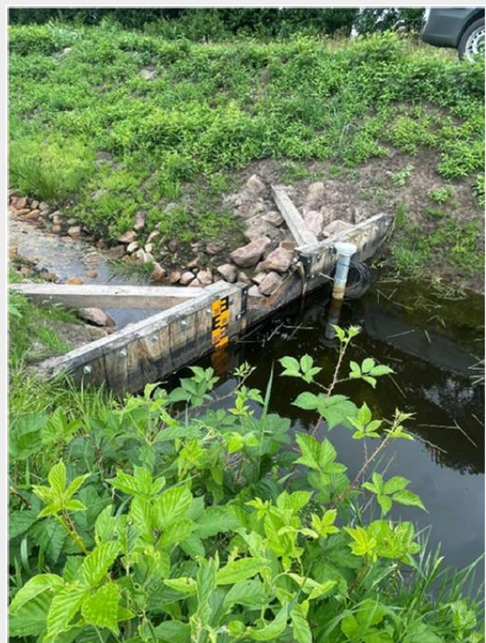
Unter Wehrkrone abgesenkter Wasserspiegel, August 2022 (Quelle: Friesoyther Wasseracht)
