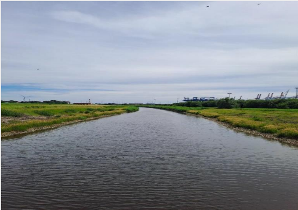
Blick auf den Grauwallkanal vom Siel in Weddewarden (Quelle: Landkreis Cuxhaven)
