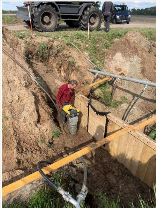
Bau des Wehres (Quelle: Friesoyther Wasseracht)
