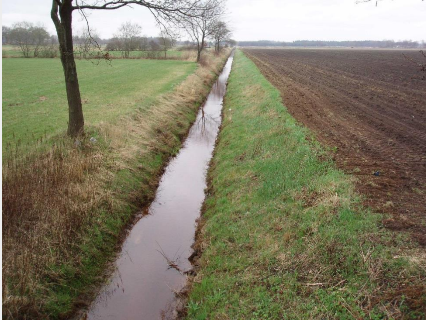
Beispiel eines aufgestauten Entwässerungsgrabens (Quelle: NLWKN)
