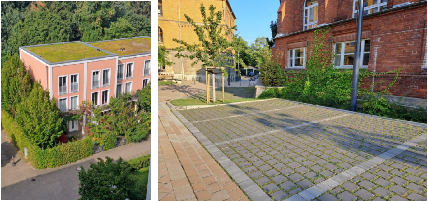
Abbildung 33: Beispiel für eine Dachbegrünungsmaßnahme (links) und neu gestaltete Parkfläche mit versickerungsfähigen Rasenfugensteinen (rechts) (Quelle: LBEG)
