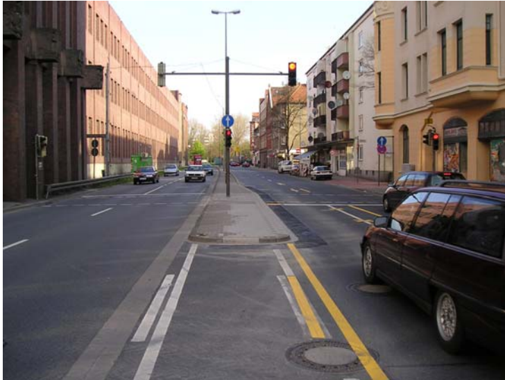
Abb. 5: Verbreiterung der Mittelinsel der LSA im Nahbereich der Verkehrsstationen – Stand 20.4.2005, Blick nach Norden
